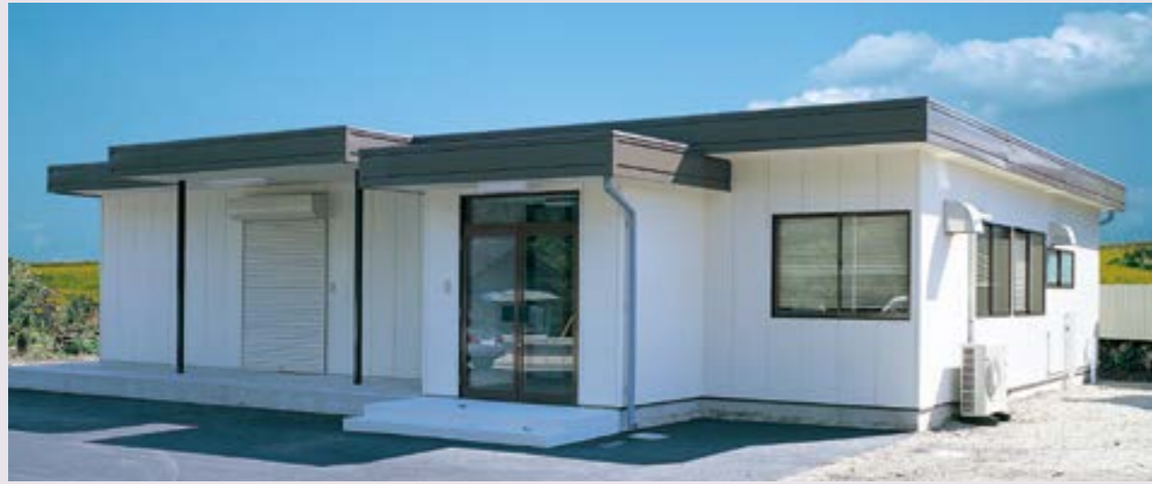
8. 事務所兼倉庫
