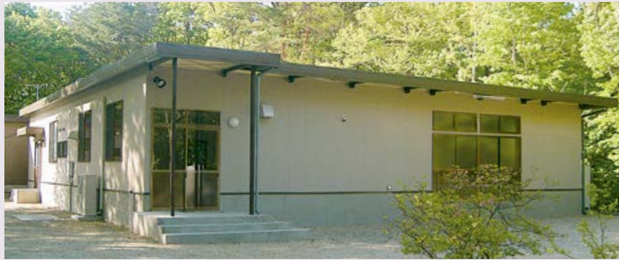
9. 事務所兼倉庫
