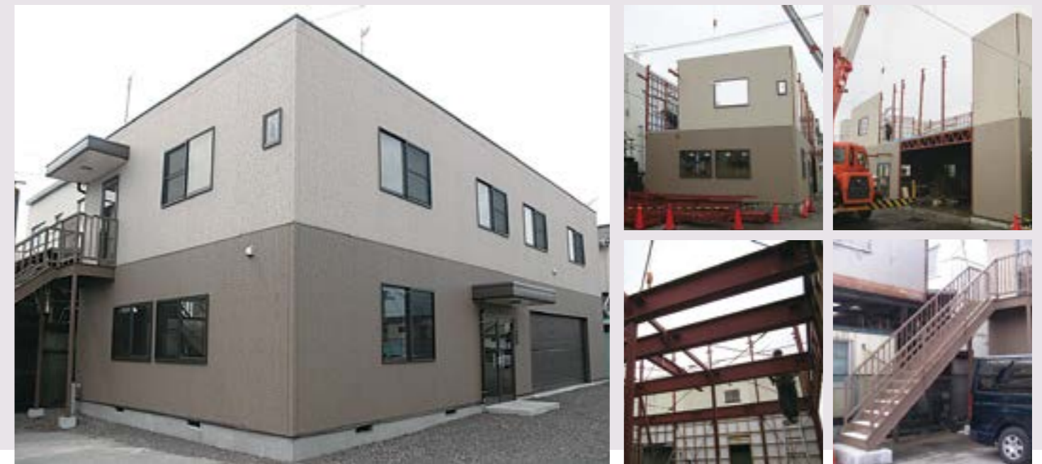
3. 事務所兼倉庫
