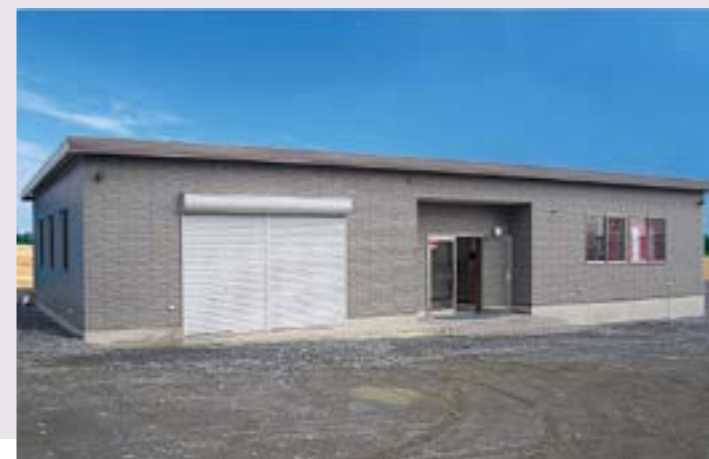
13. 事務所兼倉庫
