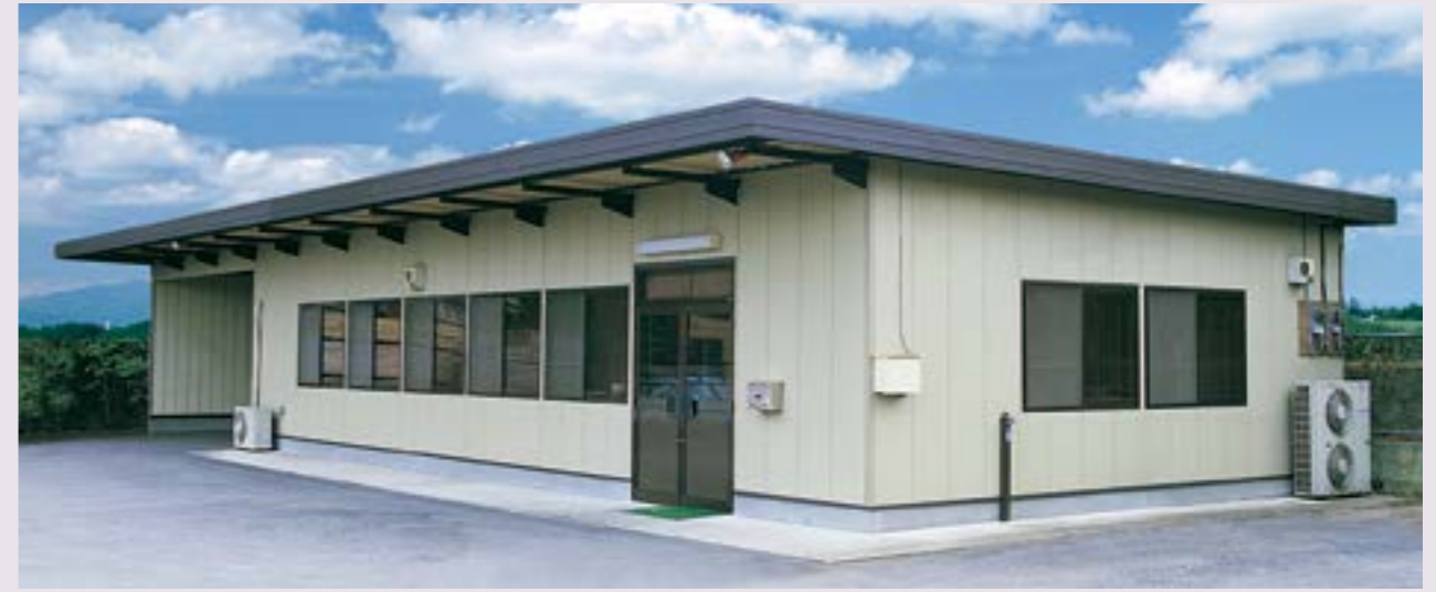
11. 事務所兼倉庫
