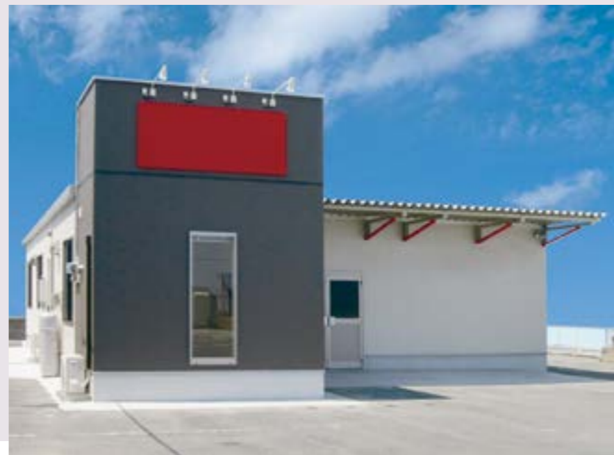
7. 事務所兼倉庫
